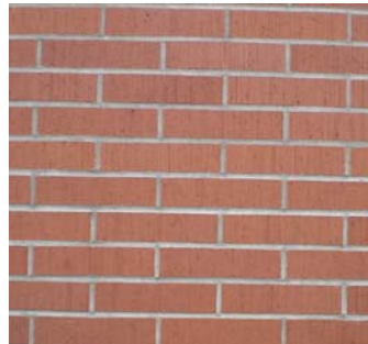
Sichtbacksteinmauerwerk Coop Bestehend aus dem Jahre 1967
